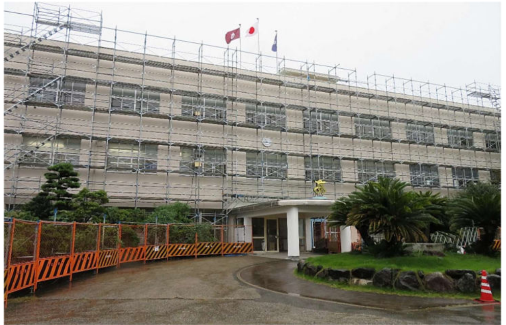
正門から見た改修工事中の 1 棟 (令和 2 年 11 月 5 日撮影)
