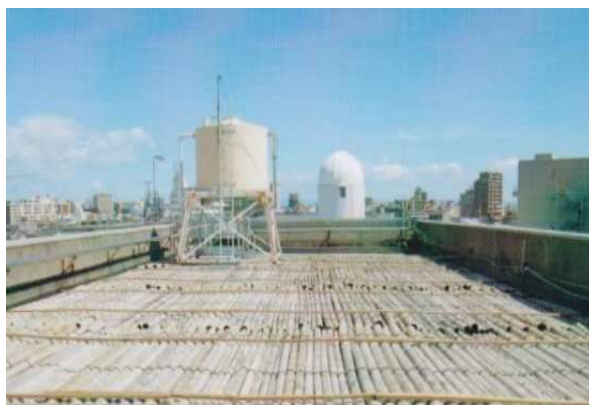
屋上の敷設現場
