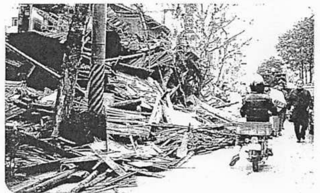
倒壊した民家が道路をふさぐ (95.1.17日 午前8時30分 神戸・東灘区で)
