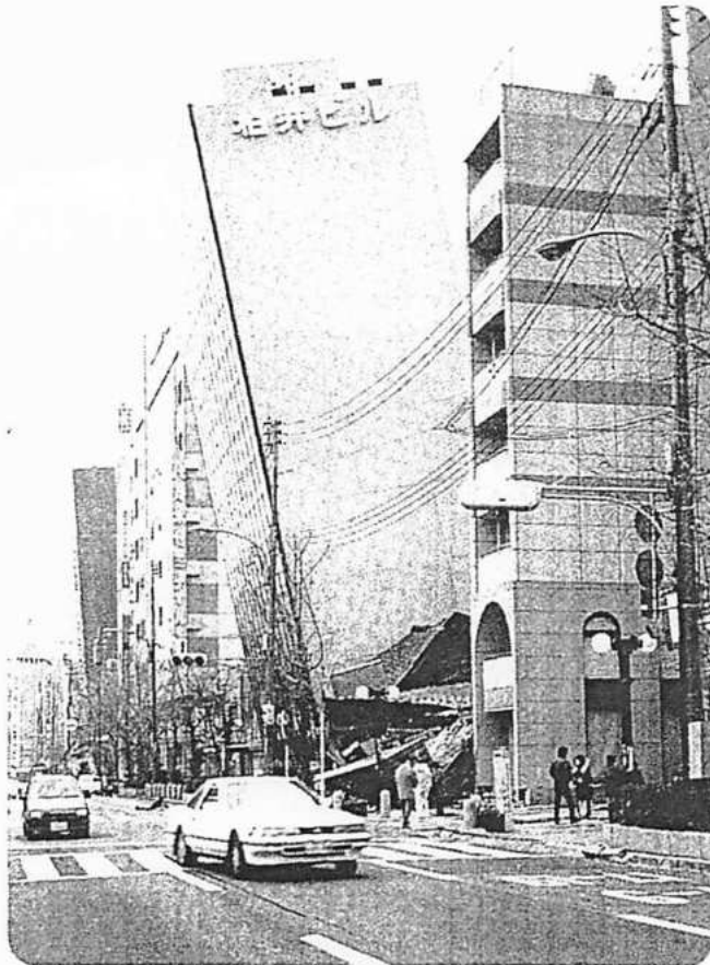
傾くビル。2時間後に倒壊した。神戸の三宮で。(95.1.17日 午後7時)
