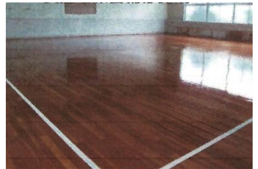
武道館の床面の補修
