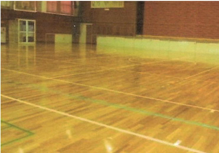
体育館の床面補修
