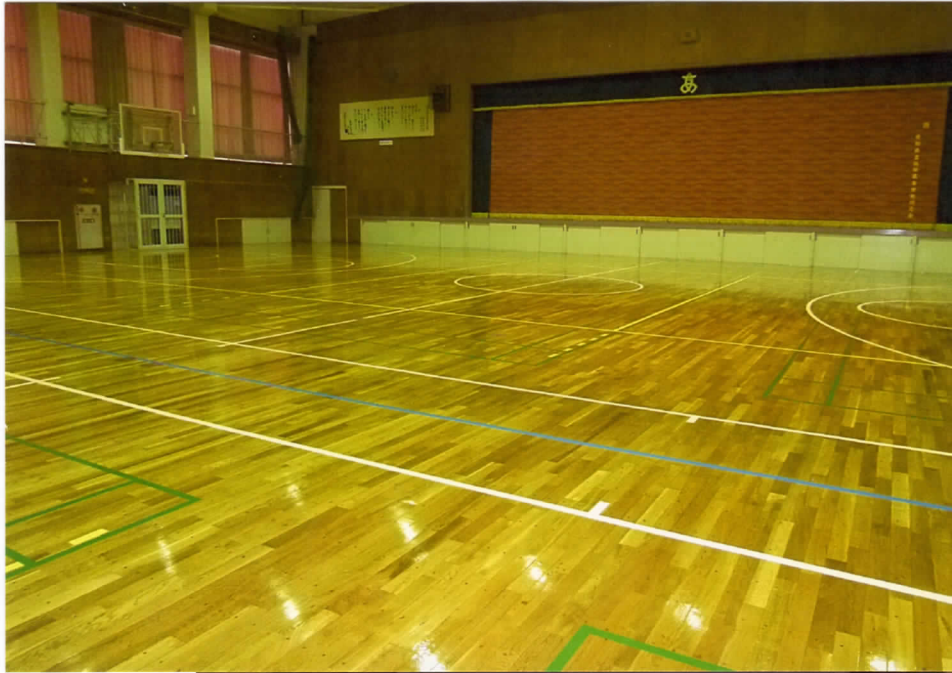
体育館の補修完了（緞帳・空調機器・床面補修）
